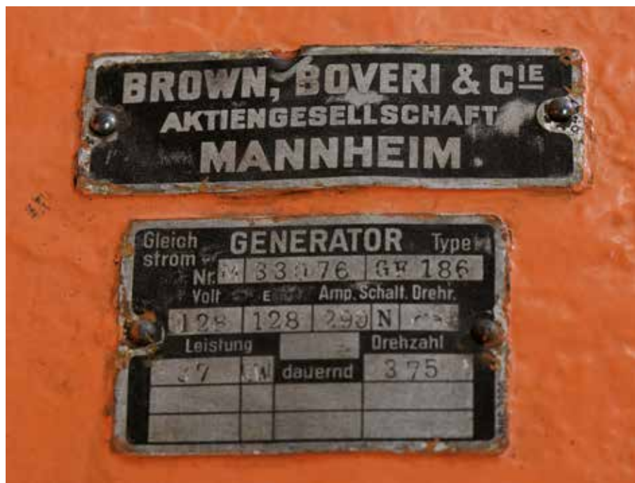
Tvornička pločica Brown Boveri na generatoru Hidroelektrane Jaruga
