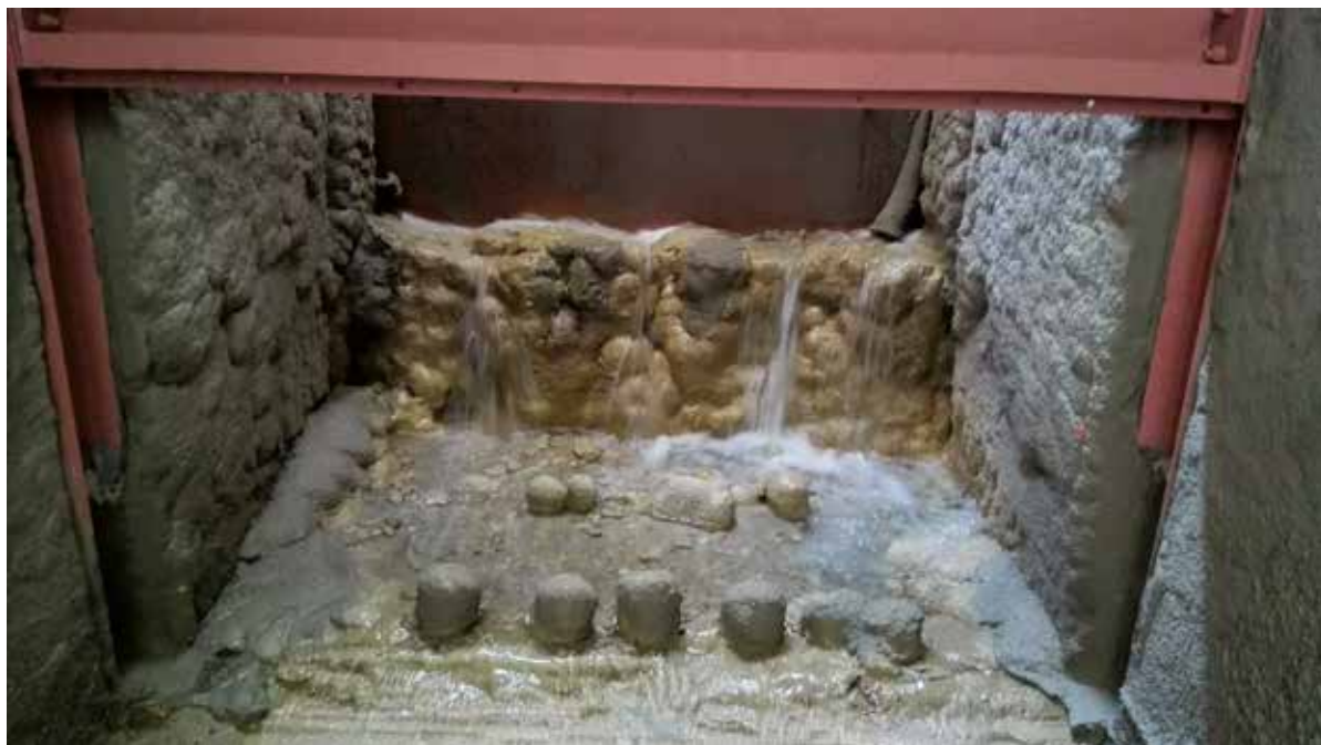
Sedra na ulaznom kanalu
