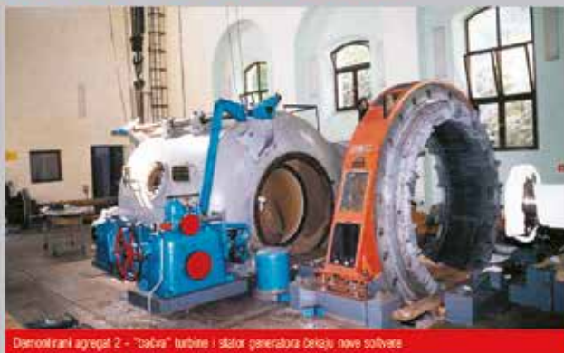
Demontirani agregat 2 - "bačva" turbine i sklop generatora čekaju nove softvere
