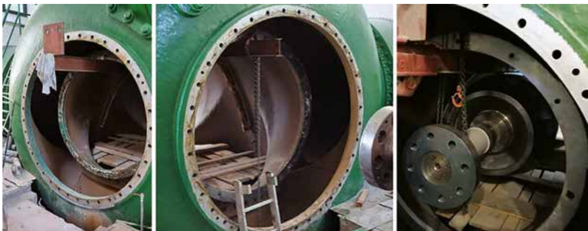
HE JARUGA- Kapitalni remont turbine, montaža pregradne bačve (Interna dokumentacija HEP-a)
