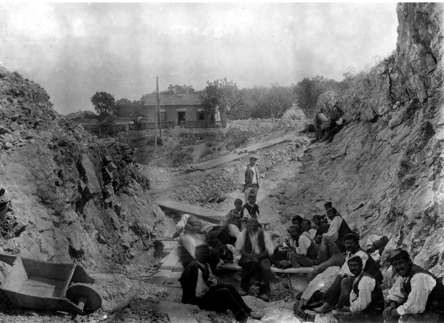
Radnici pri izgradnji hidroelektrane Krka
