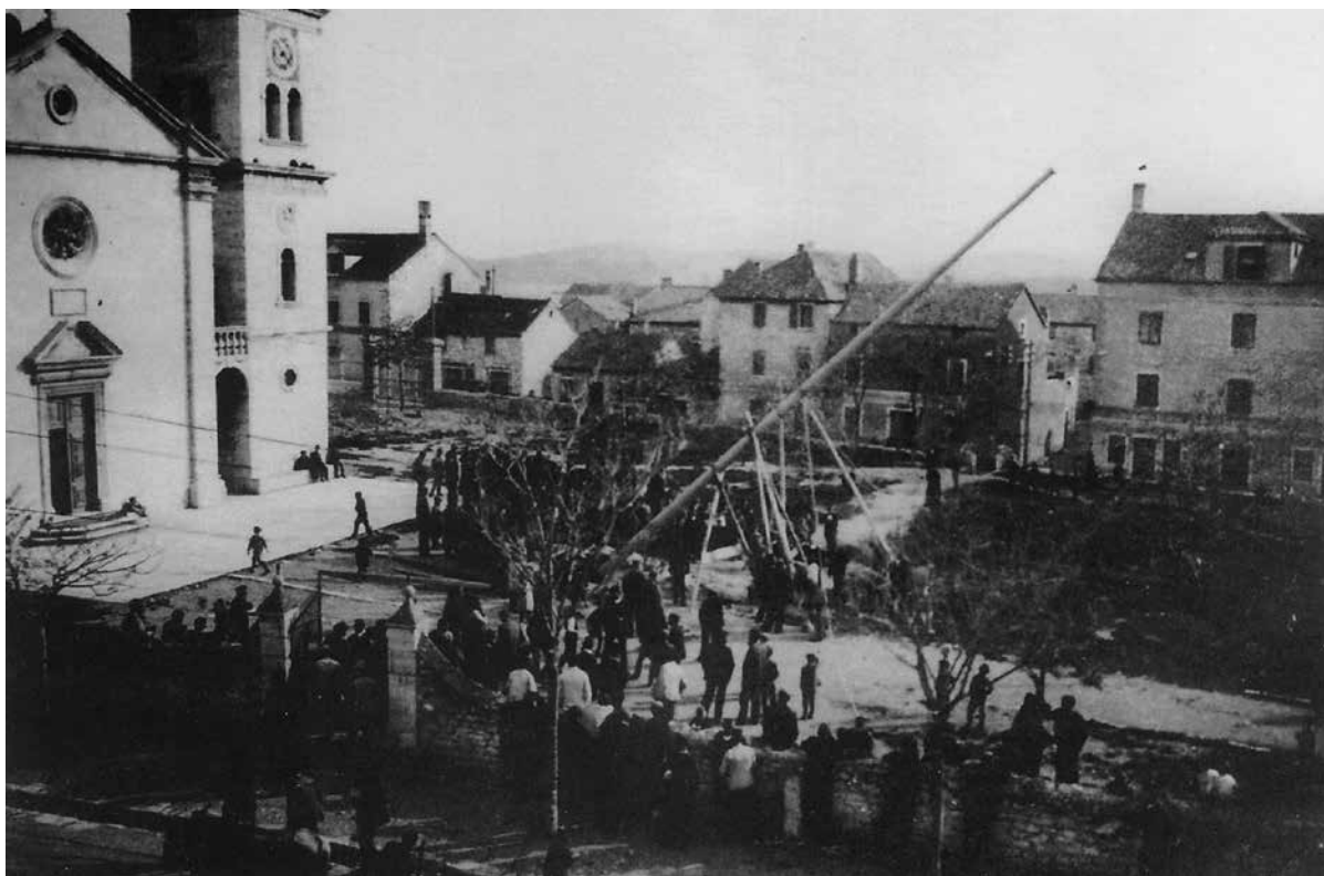
Postavljanje električnog stupa za javnu rasvjetu u Šibeniku 1895.
