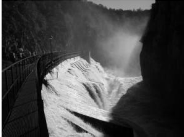
Fig. 12. Side spillway on headrace canal
