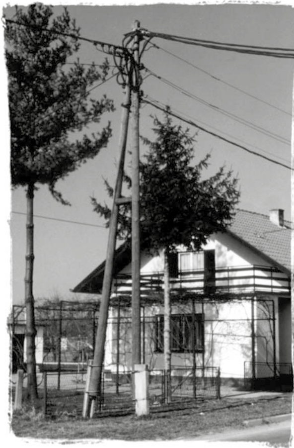
Drveni A stup s kombinacijom Elkalex i golih vodiča
