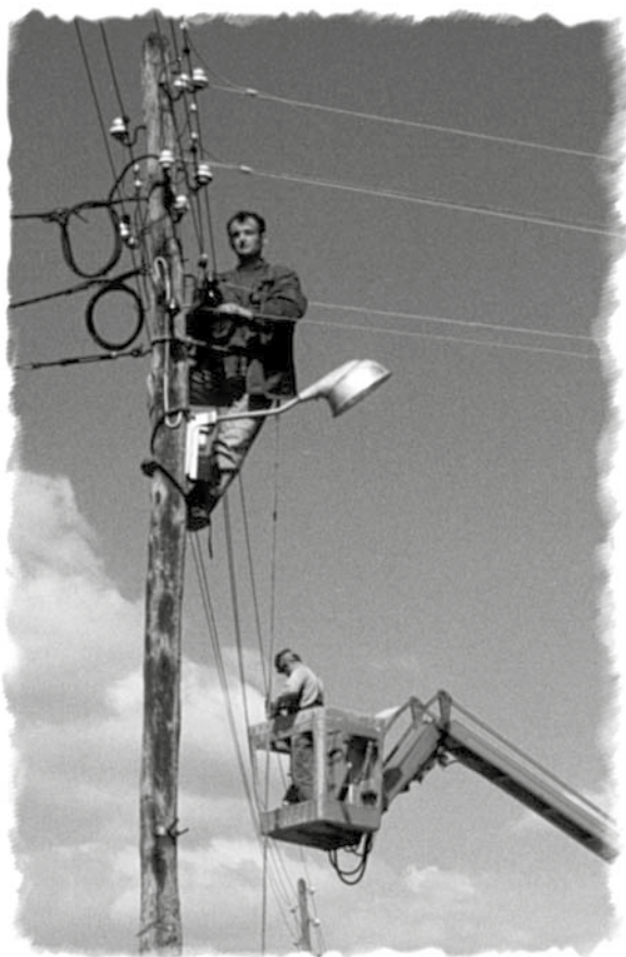
Nenad Pantelić monter – zamjena vodiča u selu Rešetari
