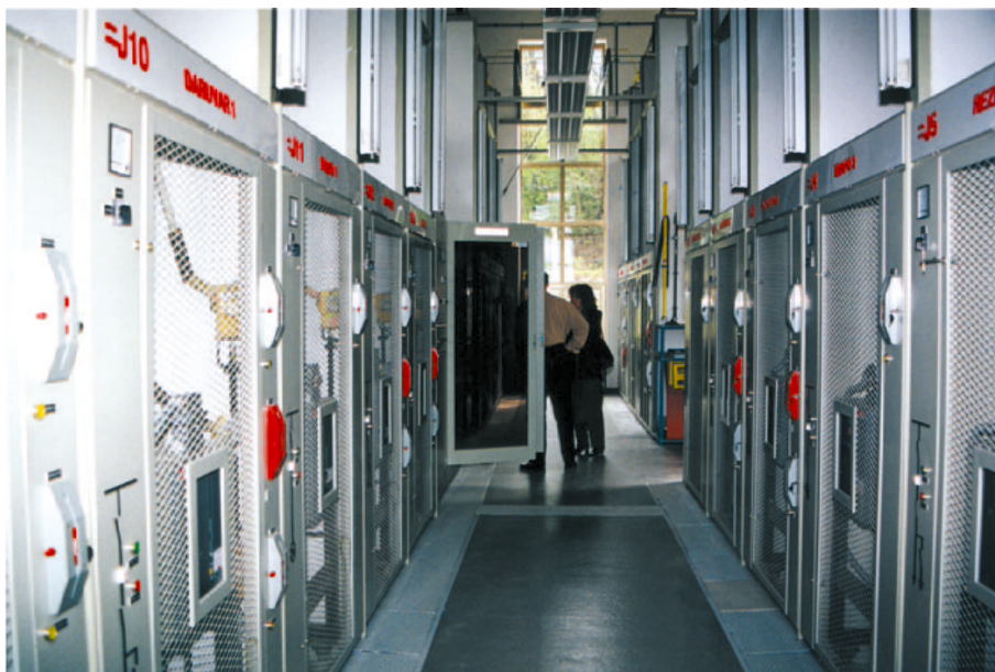
Unutrašnjost TS Daruvar 35/10 kV, posljednje transformatorske stanice koja je uključena u Sustav daljinskog upravljanja u DP Elektra Kríž
