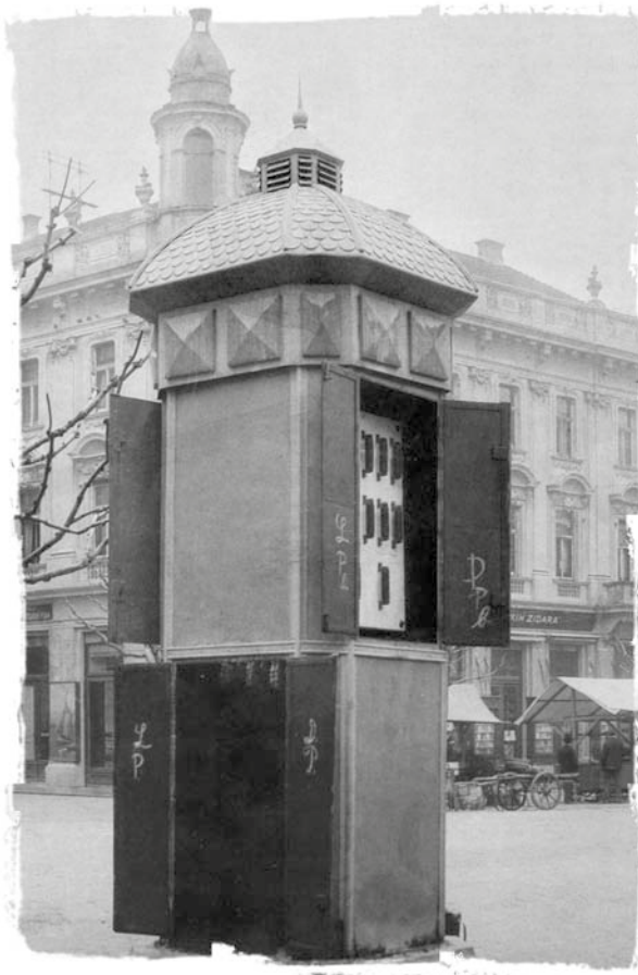
Jedna od prvih transformatorskih stanica 5 kV u Zagrebu
