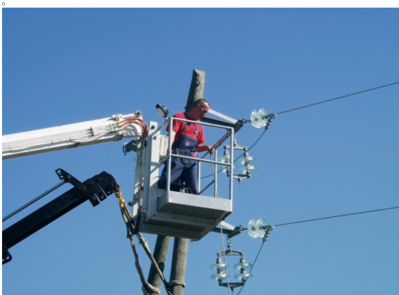
○ Popravak visokonaponskog dalekovoda
