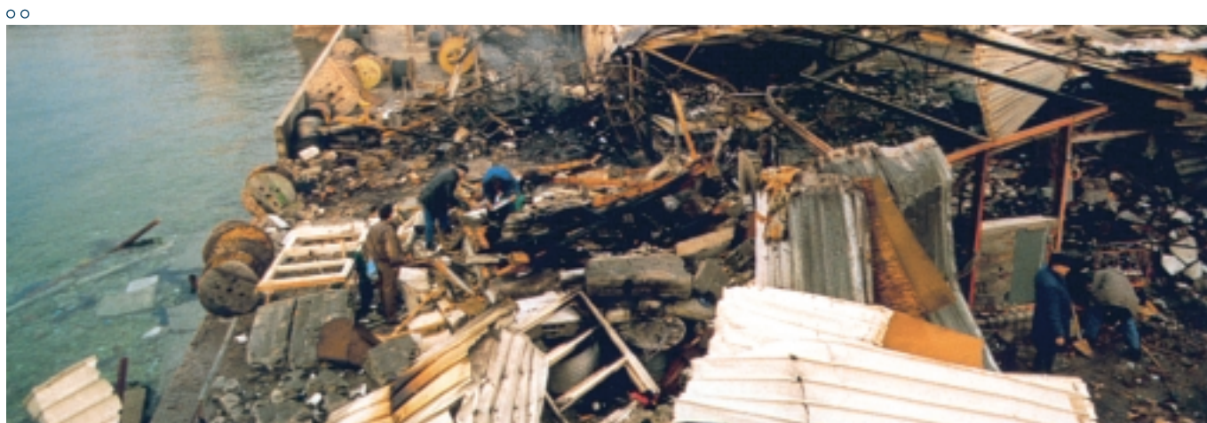
○ _____ Skladište uz poslovnu zgradu Elektre Zadar u požaru nakon izravnoga pogotka
