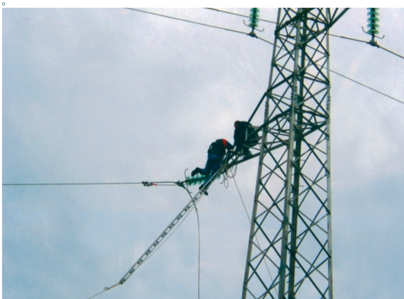
○ Popravak na dalekovodu 35 kV Obrovac - Seline
